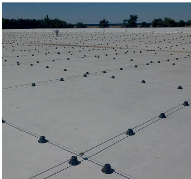
На плоских крышах держателей с утяжелителем приклеивать не надо. Держатель 12140 обладает замком для фиксации проволоки.
