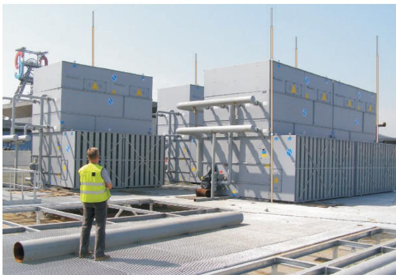
Использование изолированного молниеприемника АН Hardt 375 kV, установленного на держателях, монтируемых непосредственно на вентиляционных коробах позволяет отказаться от отдельно стоящих мачт громоотвода, установленных на подставках и постаментах.
